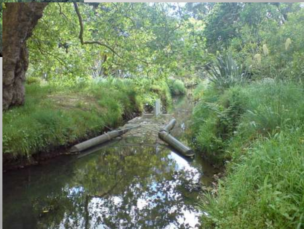
Peldošu atkritumu uztveršanas ierīce, Oklenda, Jaunzelande.
