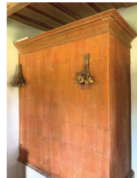
Temperatūras stabilizācija (termiskā masa) vecajās ēkās. Podiņu krāsns.
