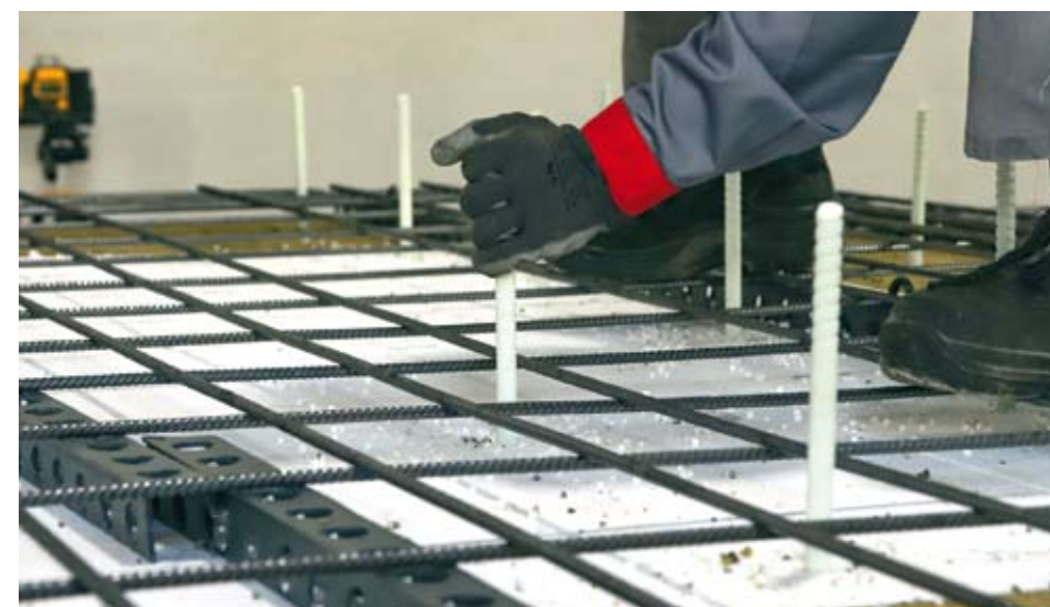
5. attēls. Isolink ® uzstādīšana.
