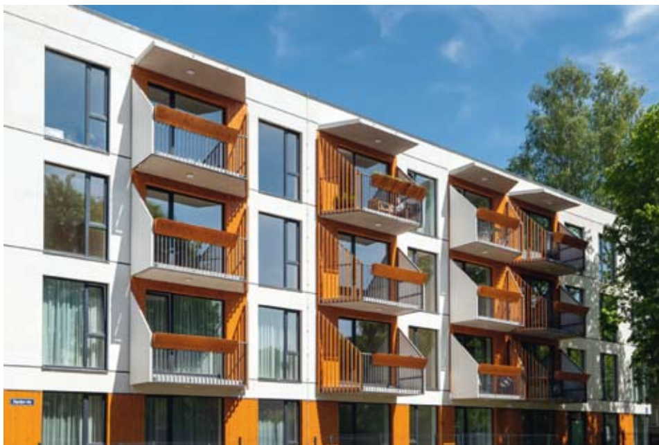
Ēka bez pārspilētiem un nevajadzīgi lieliem logu laukumiem un pārkarēm, kas ar nodrošina zināmu noēnojumumu.
