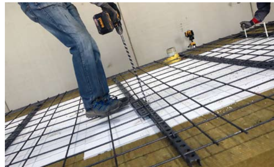
4. attēls. Caurumu urbšana izolācijas materiālā.
