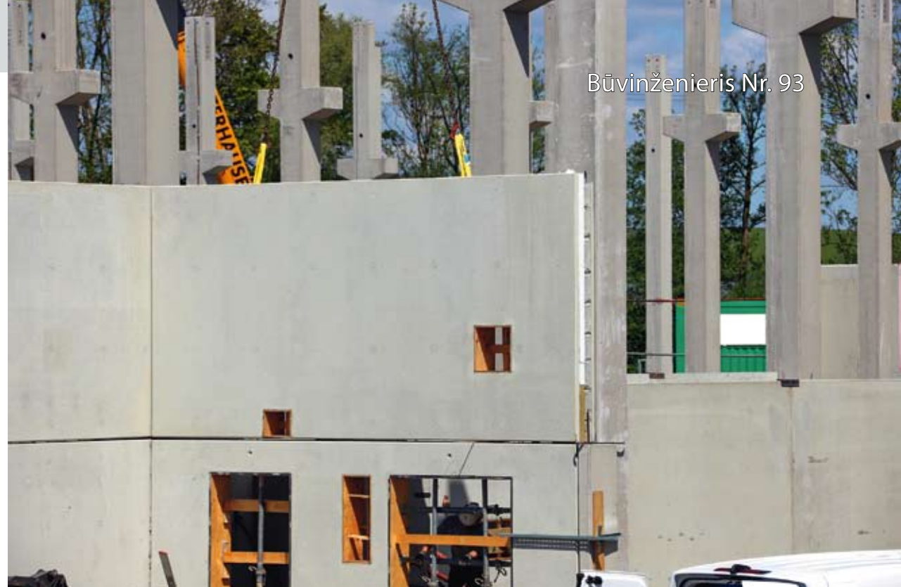
8. attēls. Izolētas sienas ar Schöck Isolink ® C tipa stiprinājumiem montāža objektā.
